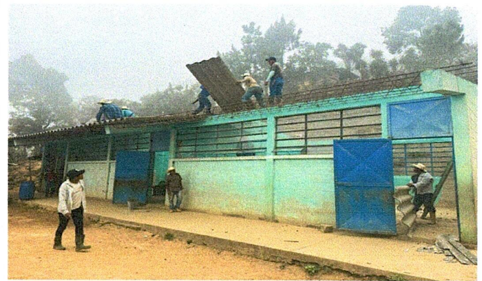
Foto 2: Pintura en muros interiores y exteriores.
