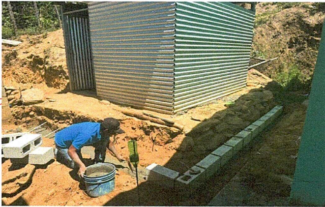
Foto 1: Reparación y sustitución de Área de cocina.
