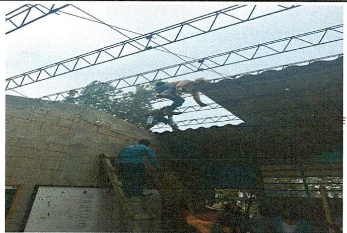
Foto 4: Cubierta de lamina.
